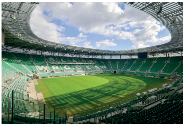
Murawa podlewana retencjonowaną w zbiornikach wodą opadową.
