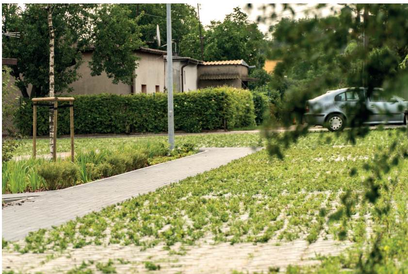
Nawierzchnie przepuszczalne na osiedlu Meksyk. Fot. Laboratorium Innowacji Społecznych, Gdynia.
